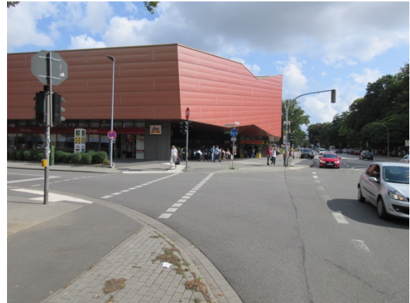
weit abgerückte Furt, große Abbiegeradien und Konfliktpunkt mit dem Radverkehr an der Einmündung Mühlenstraße /Möllner Landstraße
