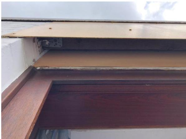
*Ungedämmtes Element oberhalb der Fenster im OG*
