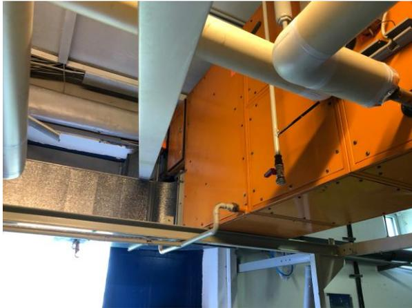
*Lüftungsanlage mit Wärmerückgewinnung*
