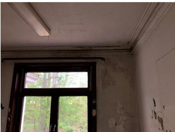
*Innenansicht 1. OG mit Fenster mit Feuchteschäden oberhalb des Fensters*
