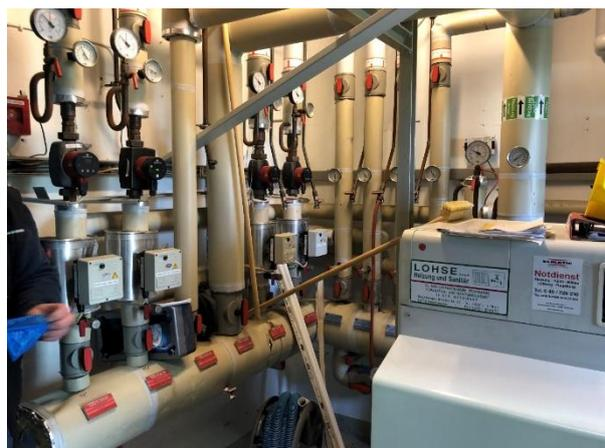
*Pumpen und Verteilung, tlw. ungedämmt / wenig gedämmt*
