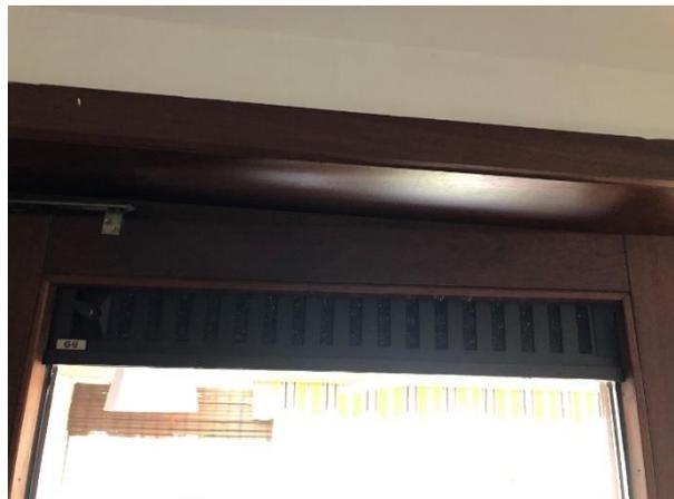
*Lüftungselement in einem Türelement, thermisch nicht entkoppelt, Fenstertür ist relativ undicht*
